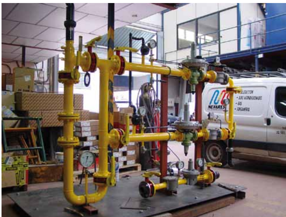
Fabricación de Estación de Regulación y Medida de Gas.
