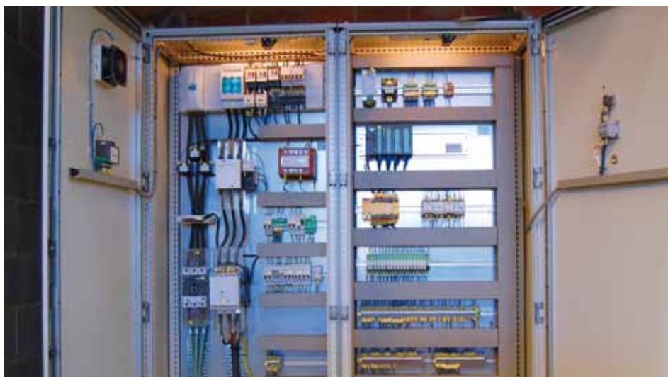
Armario de maniobra para prensa de tres mil toneladas.
