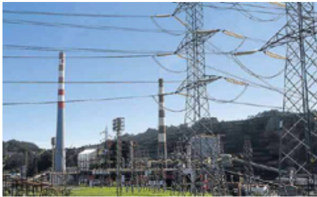
Instalaciones de la central térmica de Aboño, propiedad de EdP. :: DANIEL MORA
